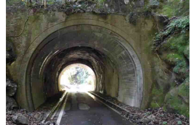
林道菊池人吉線 (トンネル2) 延長67m 幅5.5m 高さ5.2m
