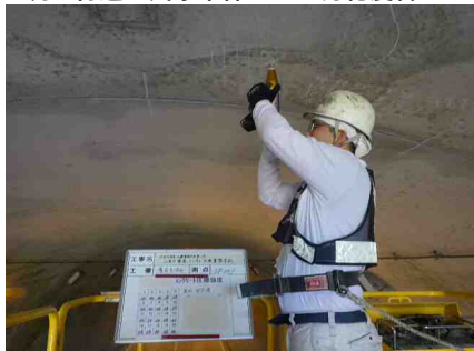
首石トンネル
