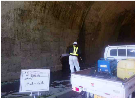
首石トンネル
