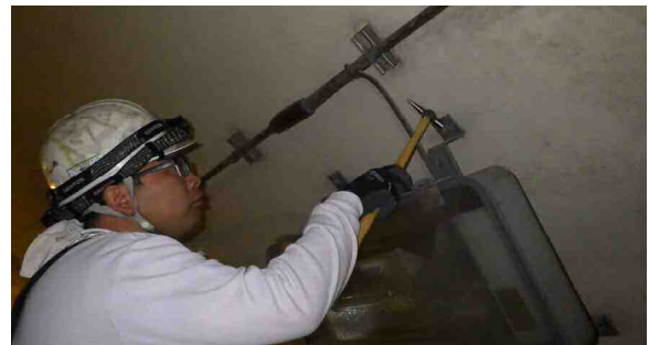
設備近接目視状況
