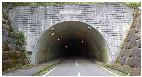
内野黒猪トンネル 鹿本地区広域農道(鹿本2期地区) 延長368m 幅6.5m 高さ4.7m
