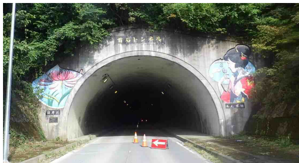
首石トンネル 鹿本地区広域農道(鹿本2期地区) 延長1190m 幅9.75m 高さ4.7m (NATM工法)
