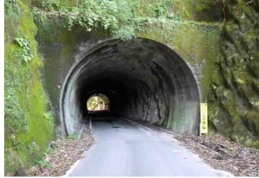
林道菊池人吉線 (トンネル1) 延長67m 幅5.5m 高さ5.3m
