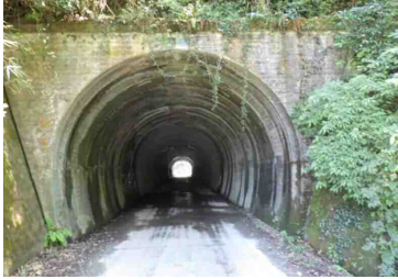
林道菊池人吉線 (甲馬隧道) 延長111m 幅5.4m 高さ5.1m
